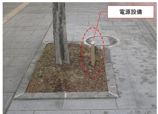
道路占用許可に基づき設置された電源設備
