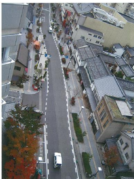
社会実験の様子 (H19 秋・車道の蛇行、センターライン消去)
