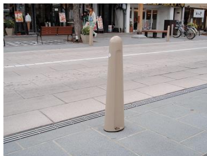
歩車道分離施設 （可動式ボラード）
