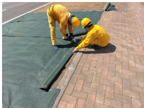
高田かわこくも 防草シートを設置し協力
