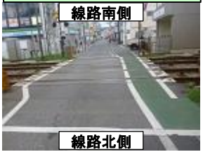
対策後(カラー舗装)
