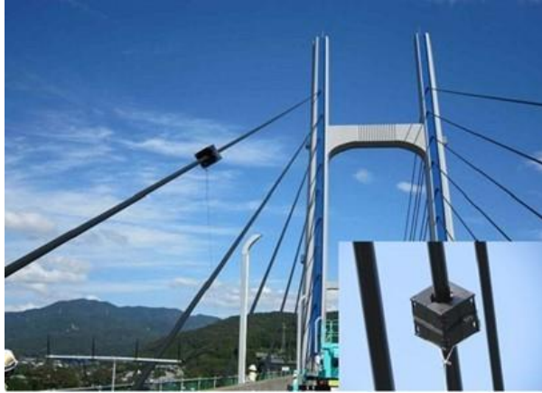
測定状況の例
