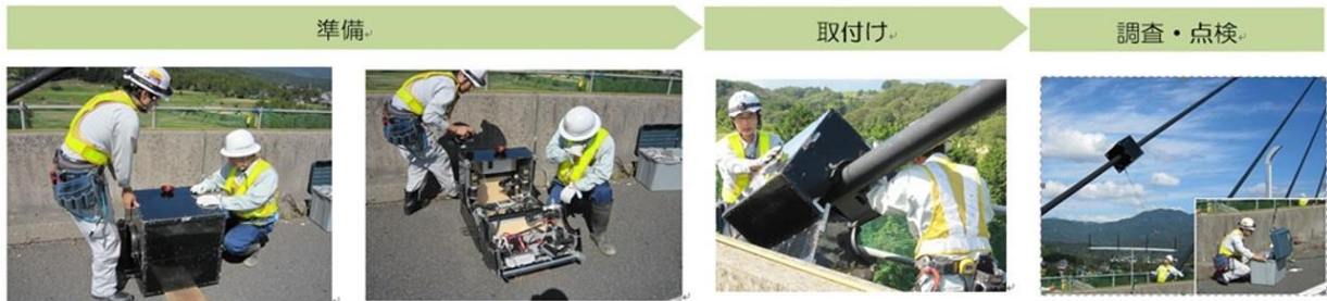
斜材点検の手順
