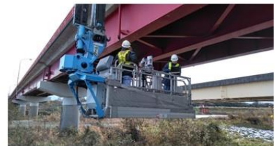
橋梁点検車からの撮影
