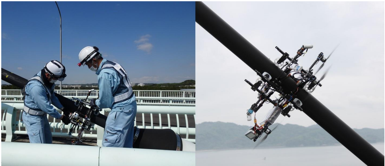
機体取付状況及び稼働状況
