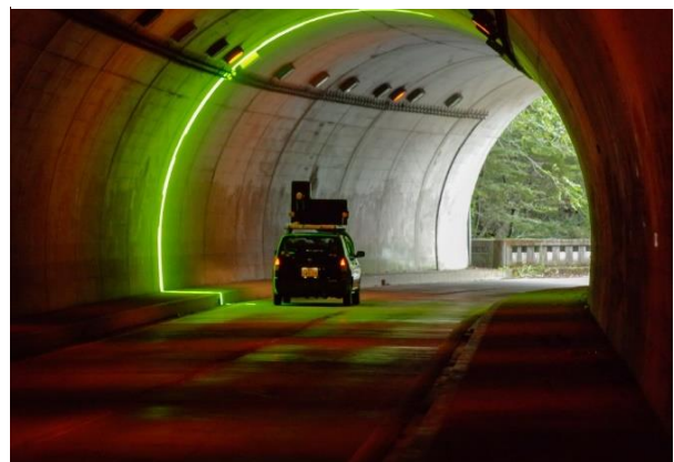
トンネル計測の様子
