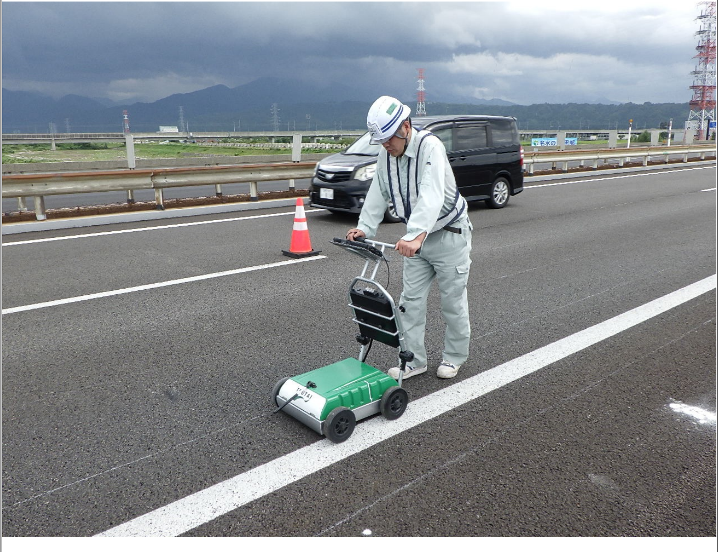
点検状況(昼間)
