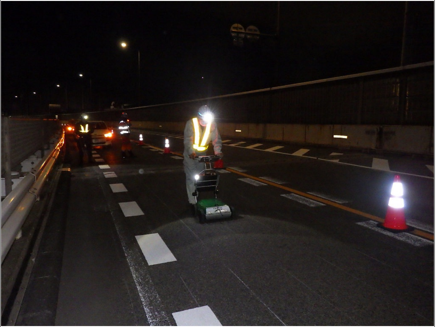
点検状況(夜間)
