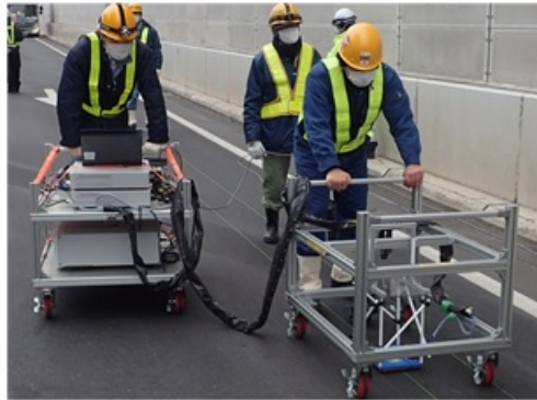
実橋梁での点検作業例
