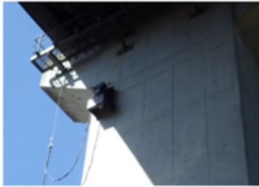
点検実施状況
