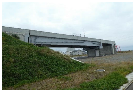
写真-1 全体写真
