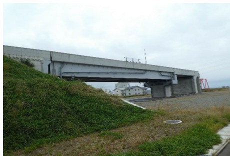
写真-1 全体写真
