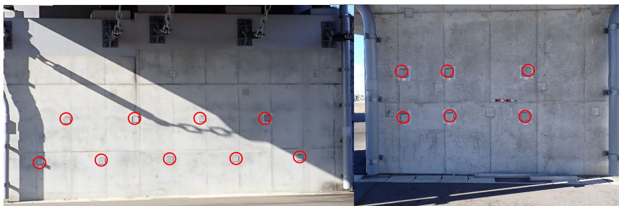
写真-1:A1橋台(9パネル)
