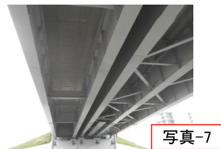
鋼単純非合成鉄桁橋(少数主桁)(写真-7)
