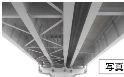
鋼単純非合成鉄桁橋(多主桁)(写真-6)
