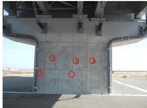
写真-2: P1橋脚 (起点側) (5パネル)
