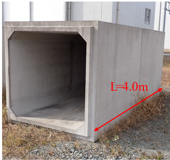
写真-2 コンクリートカルバート 奥行
