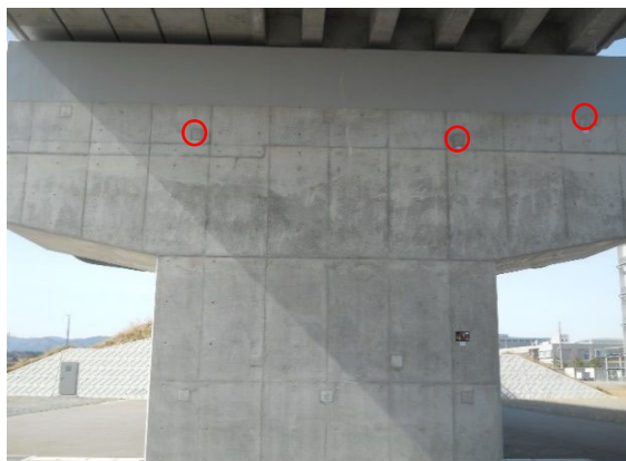
写真-3: P1橋脚 (終点側) (3パネル)
