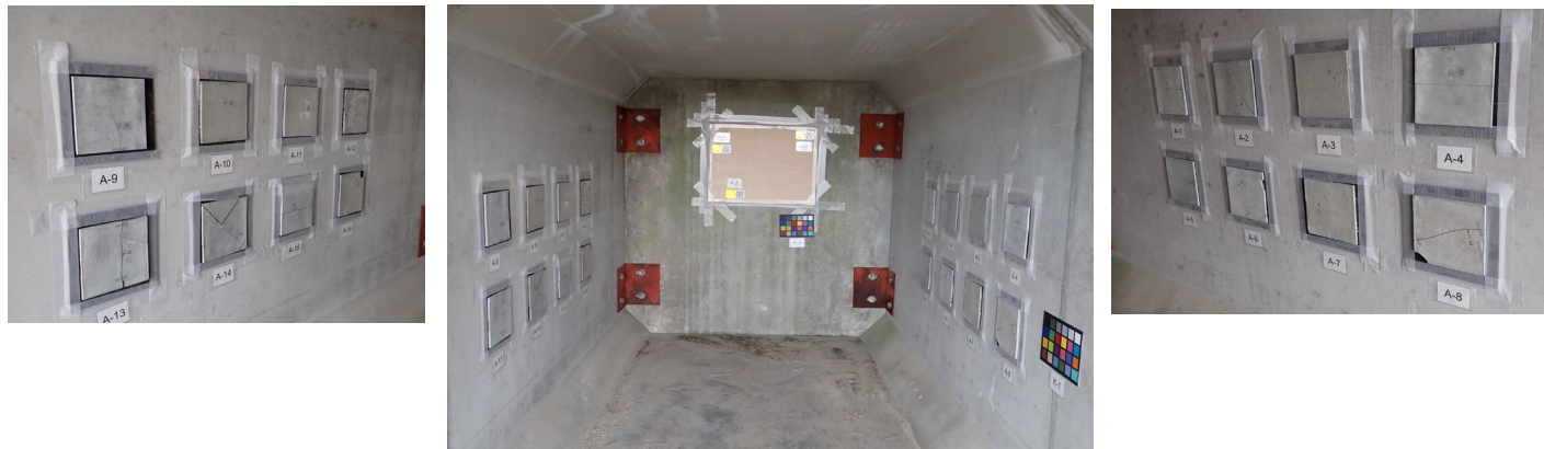
写真-1：コンクリートカルバート内部（15パネル）
