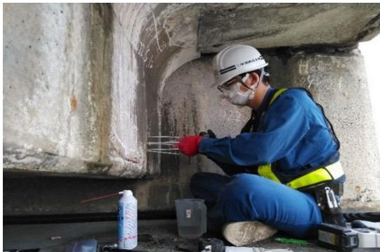
写真-3 削孔穴へスポンジ棒を挿入
