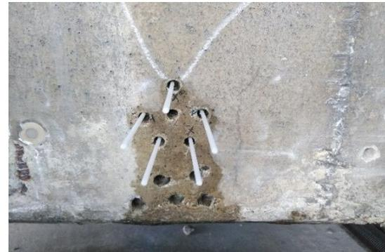
写真-4 削孔穴の湿潤養生状況
