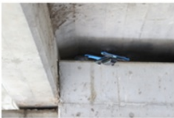
橋梁下の画像計測例
