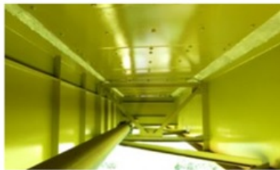
桁内の撮影例
