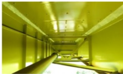
桁内の撮影例
