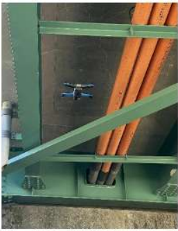
Skydio2+狭隘部侵入不可飛行状況
