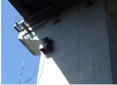
点検実施状況
