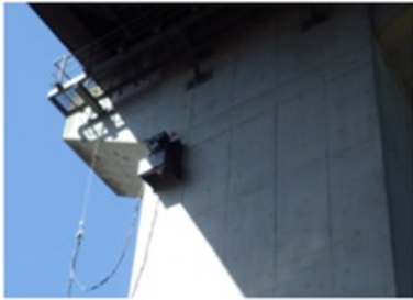
点検実施状況
