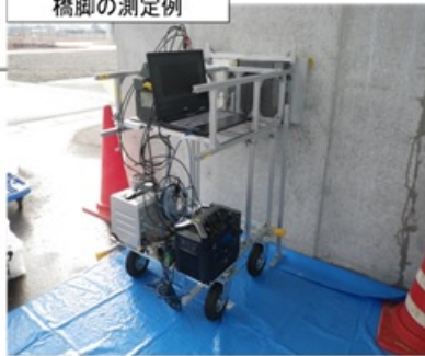
橋脚の測定例
