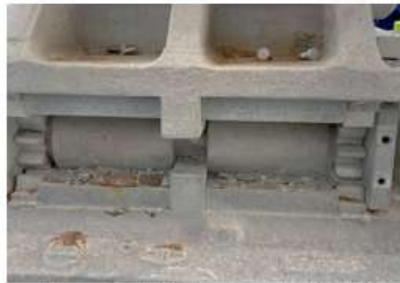
支承ローラー部(カバープレート取外し状態)
