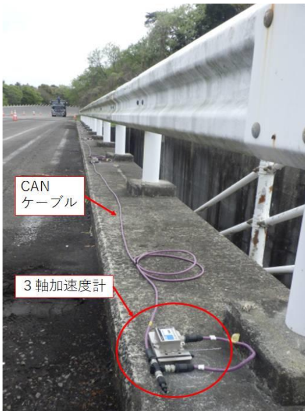
3軸加速度計の設置例 (全景)
