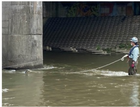
SS (水中部) 計測状況 (水深 1m未満)
