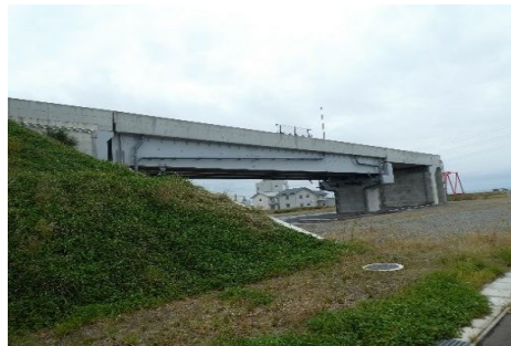
写真-1 全体写真
