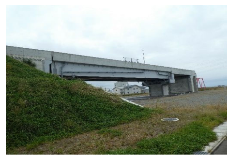
写真-1 全体写真
