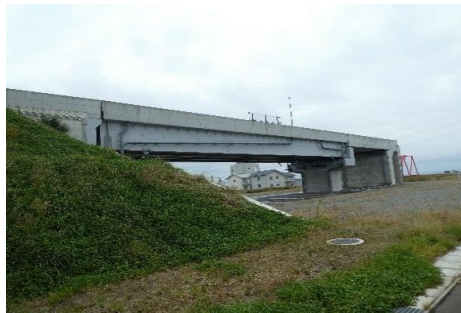
写真-1 全体写真
