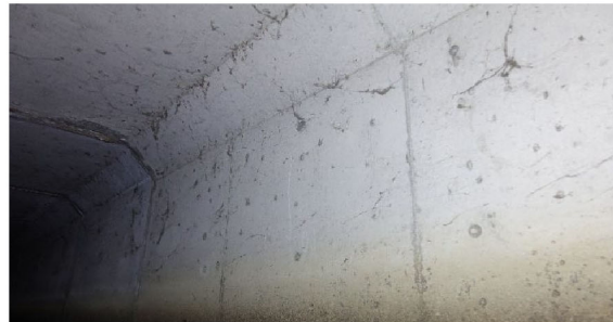
A1 側壁 ひびわれ 幅0.1mm 1000mm
