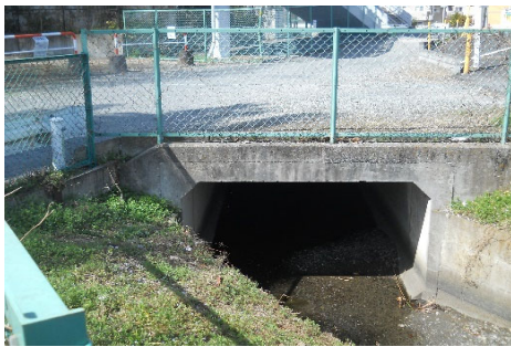
写真-1 全体写真
