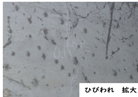
A2 側壁 ひびわれ 幅0.1mm 1000mm
