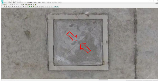
Step-1:オルソ画像上でひびわれ確認
