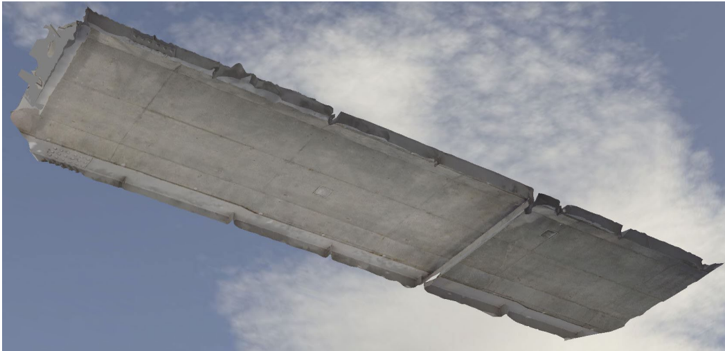
3Dデータ(A1-P1径間:鋼桁橋床版部)
