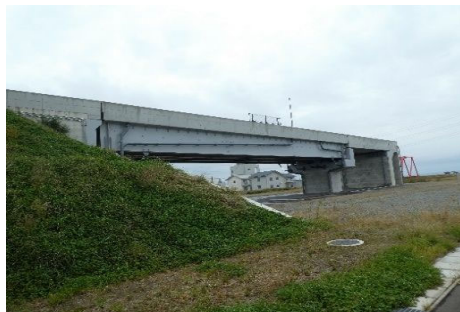
写真-1 全体写真
