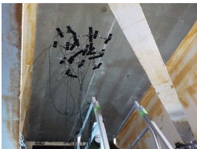
写真-7 AEセンサ設置状況(データ計測時)
