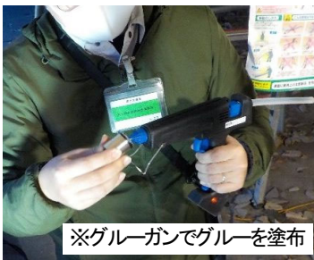
写真-4 コンクリートとの設置面にグルーガンでシリコングリスを塗布
