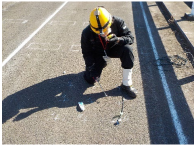
写真-10 測定対象箇所直上の 舗装面打撃(弾性波発生)
