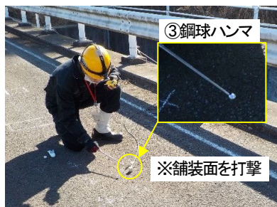
写真-8 鋼球ハンマにより舗装面打撃
