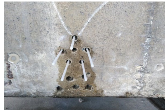
写真-4 削孔穴の湿潤養生状況
