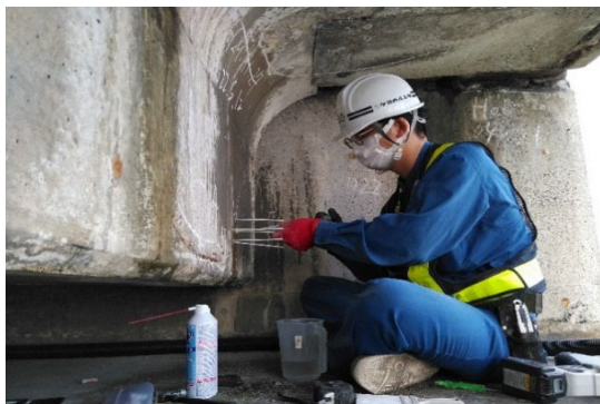
写真-3 削孔穴へスポンジ棒を挿入
