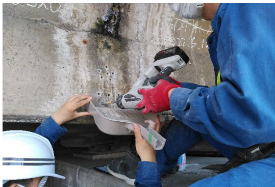
写真-1 ドリル削孔
