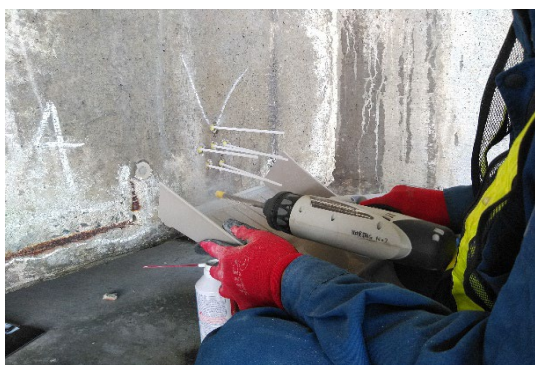
写真-1 ドリル削孔による試料採取
