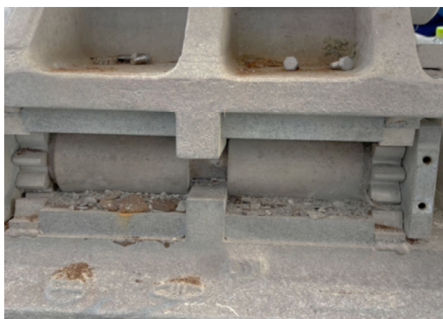
支承ローラー写真 (カバープレート撤去状態)
