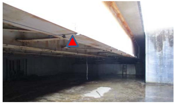
写真-2 測定対象桁及びたわみ測定位置
