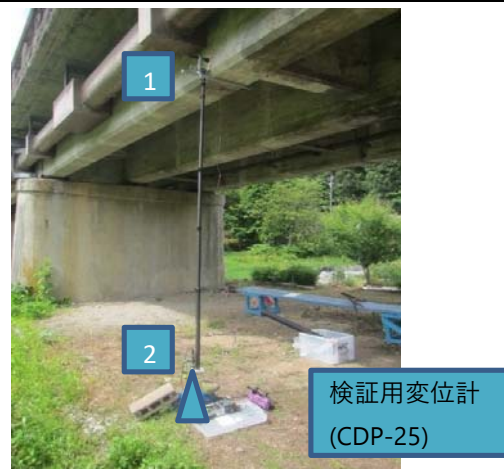
図-6 測定機器の設置(全体)
