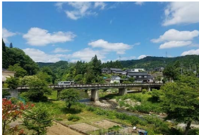
図-1 対象橋梁(T橋)
