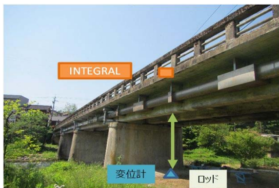
図-2 対象橋梁側面
