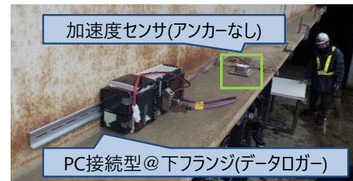
写真-5 下フランジ上に設置した計測機器
