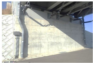
写真-2 A1橋台
