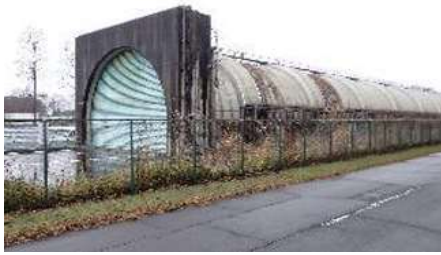
実大トンネル実験施設(坑口)
