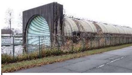
実大トンネル実験施設(坑口)
