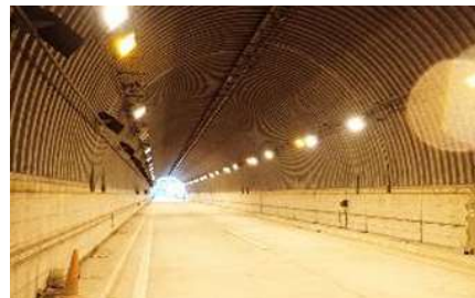
実大トンネル実験施設(坑内)
