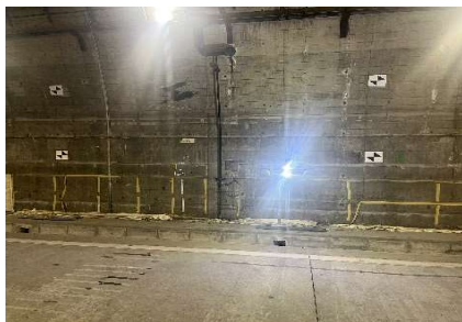
マーカー設置状況
