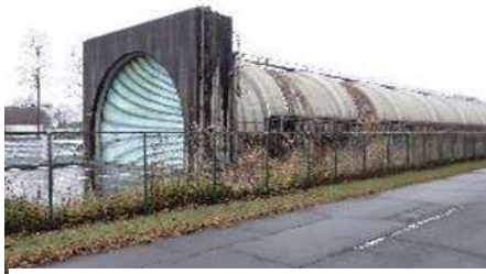
実大トンネル実験施設(坑口)
