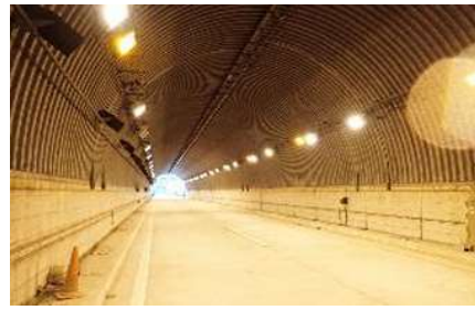
実大トンネル実験施設(坑内)
