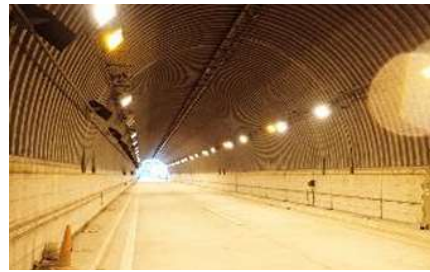
実大トンネル実験施設(坑内)
