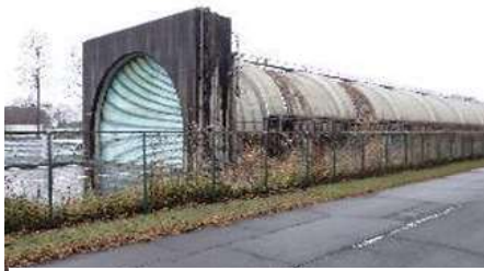
実大トンネル実験施設(坑口)
