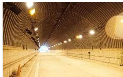
実大トンネル実験施設(坑内)
