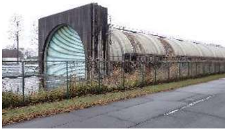
実大トンネル実験施設(坑口)
