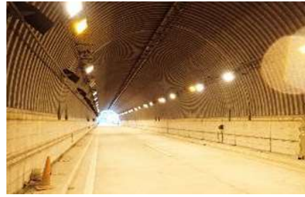
実大トンネル実験施設(坑内)
