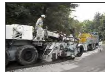
路上再生の様子
