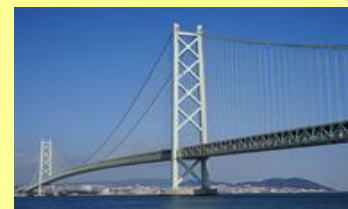
明石海峡大橋(最大支間長1,991m)
