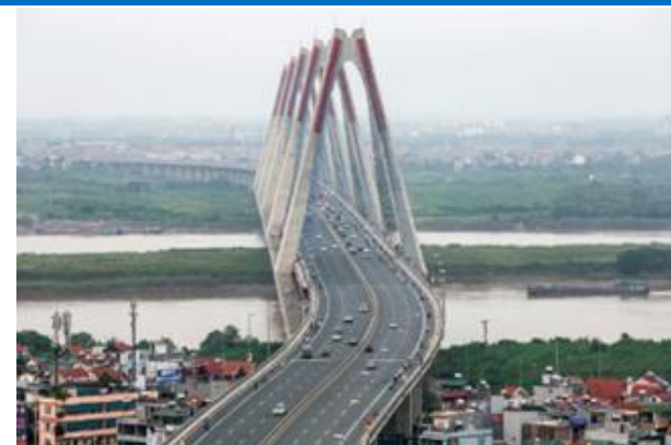
ニャットタン橋 (2015年完成)
