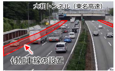
ボトルネック対策 (付加車線の設置)
