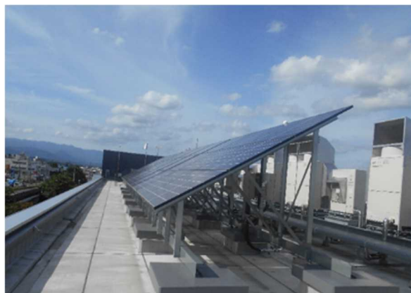
参考図 3-2 管理事務所上屋への設置事例 (東北自動車道 郡山 IC)
