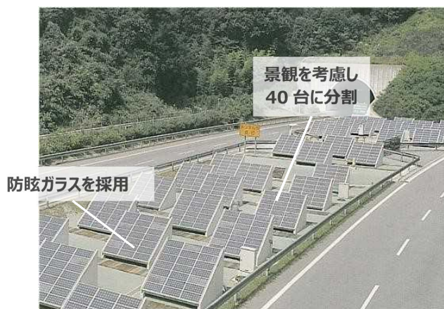
参考図 3-3 中央帯への設置事例 (北神戸線 長坂山トンネル坑口付近)
