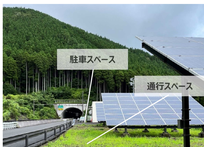
参考図 3-4 事業未着手用地への設置事例 (大長瀬トンネル電気室横平地)
