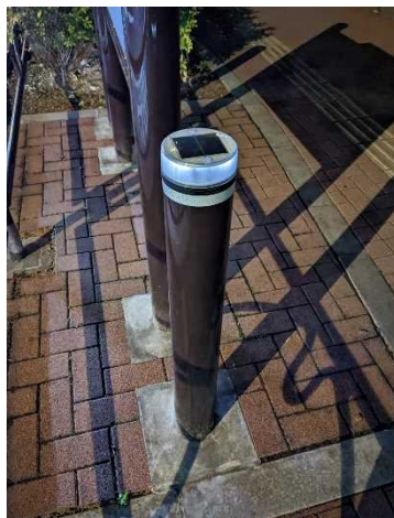
参考図 4 太陽光発電機能を有したポール型の照明の設置事例
