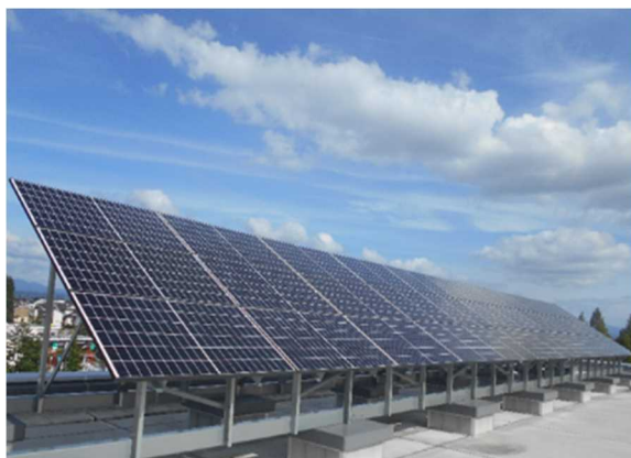
参考図 3-2 管理事務所上屋への設置事例 (東北自動車道 郡山 IC)
