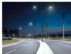
LED照明 (消費電力約56%削減)
