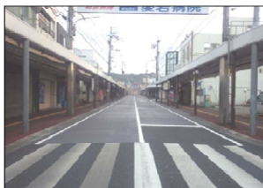
遮熱性舗装(車道部施工区間)
