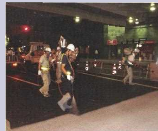
遮熱材の吹き付け
