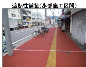
遮熱性舗装(歩道施工区間)
