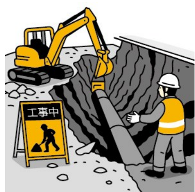
道路の拡幅工事のために必要が生じた 電柱や地下埋設物の移転工事の施行
