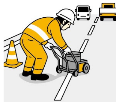
区画線の設置
