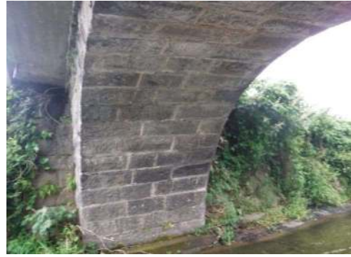
写真-2.12 目地（処理有り）
