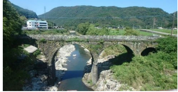
写真-2.10 橋脚を有する多径間の事例
