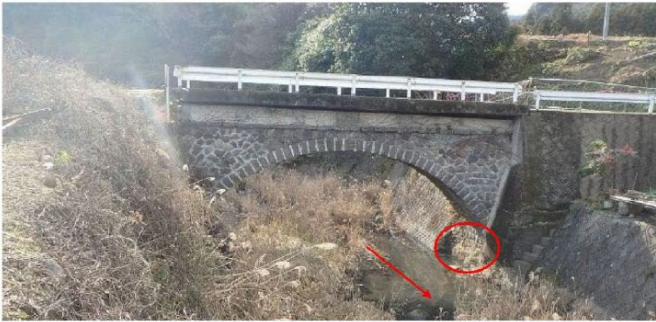
①側面(下流側)
