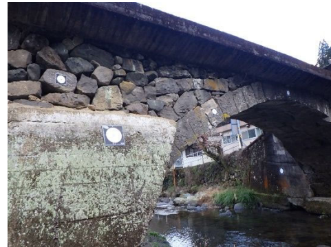
(b) 標定点設置後状況
