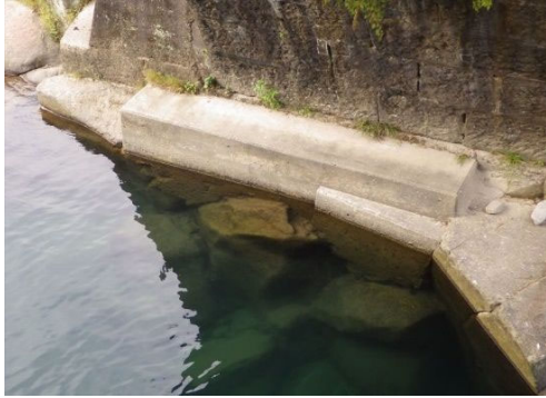
写真-2.14 基礎部分を補強している事例
