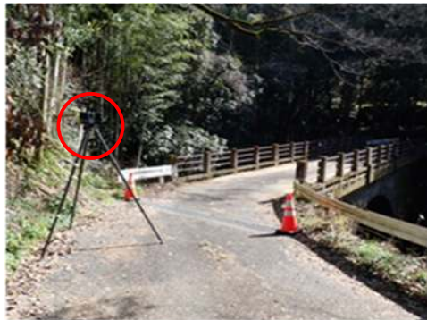
(c) レーザスキャナ計測状況
