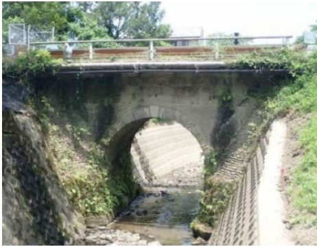
写真-2.16 石造アーチ橋の上部にコンクリート床版を設置している事例
