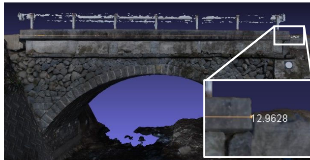
図 1-4.3 写真サーフェスモデルによるアーチ形状変化の確認（キャプチャ画像）
