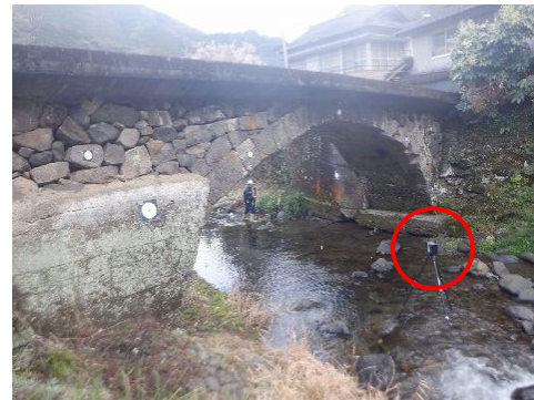
(d) レーザスキャナ計測状況
