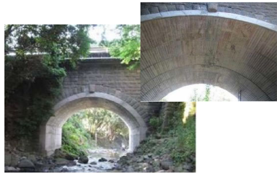
写真-2.15 輪石全体を補強している事例
