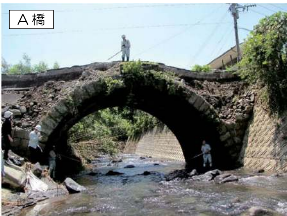
輪石・壁石が崩壊
