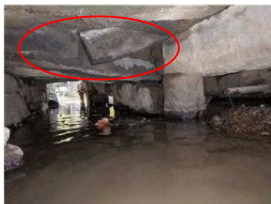
写真-付 1.3 桁の破断が橋面の舗装の異常として現れた事例
