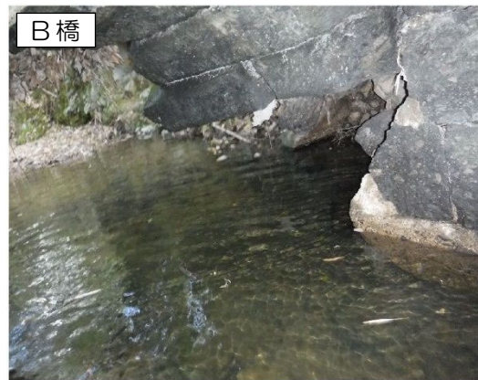
一部の断面が欠損している（輪石下部）
