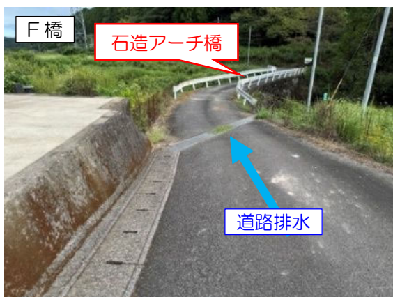
路面の状態（橋台背面方向）
