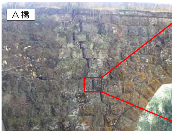
壁石に連続した開き（壁石にはらみ出しが無ければ、アーチ形状が変化した影響が考えられる）
