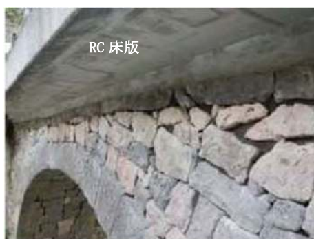
写真-1.1 石造アーチ橋のRC床版設置例
