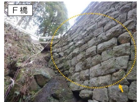
積み直し前の状態
