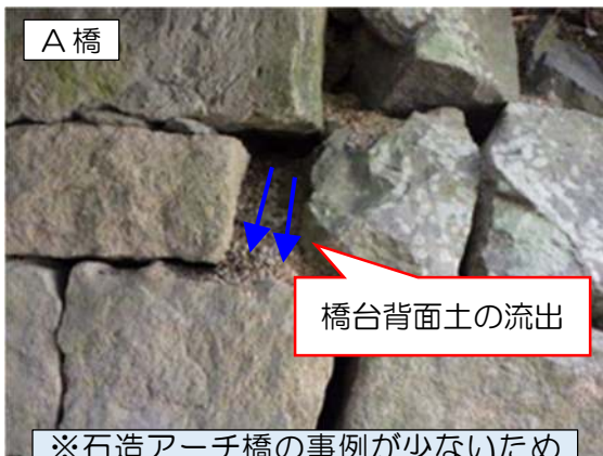
橋軸直角方向の開き（隙間）
