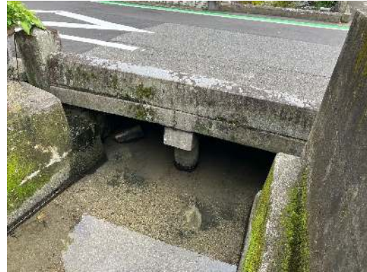
写真-1.6 橋台背面までの連続舗装
