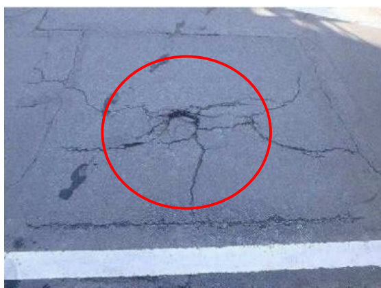
写真-付 1.3 桁の破断が橋面の舗装の異常として現れた事例
