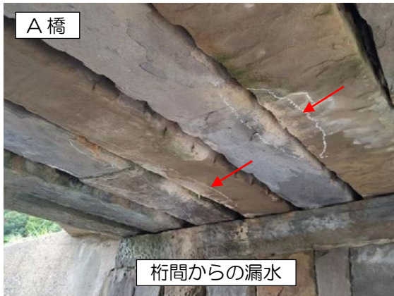
その他（漏水）のイメージ図
