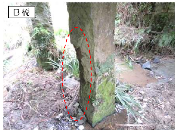
断面欠損のイメージ図
