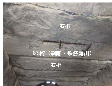
写真-1.2 石桁橋のRC桁置換事例
