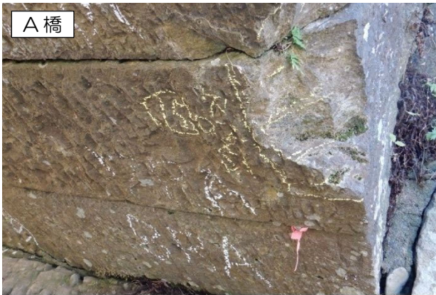
一部の断面が欠損している（輪石下部）
