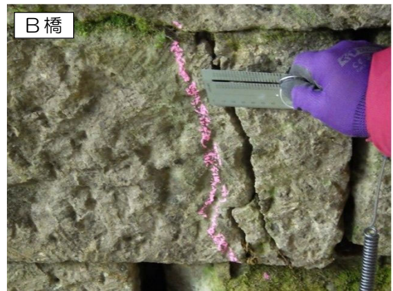
破断が生じている（輪石）
