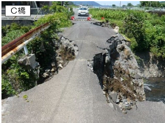
輪石・壁石が崩壊
