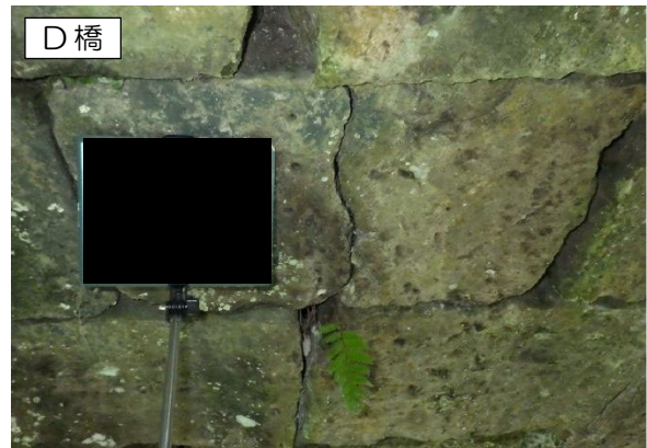
破断が生じている（輪石）
