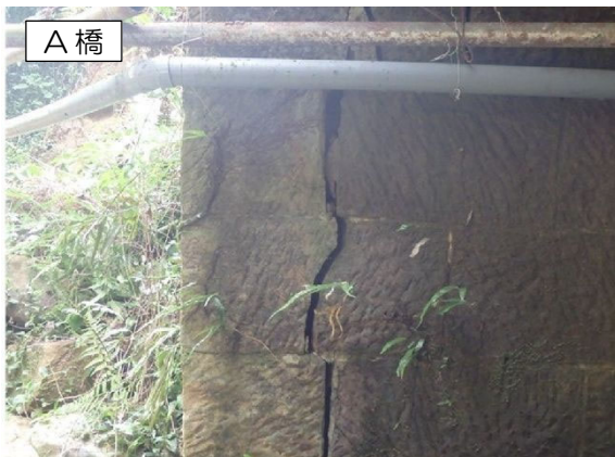
破断が生じている（輪石）
