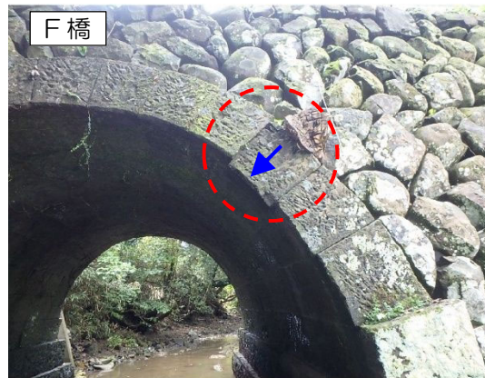
樹根貫入による輪石のずれ
