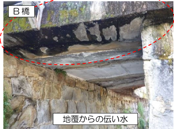
その他（漏水）のイメージ図
