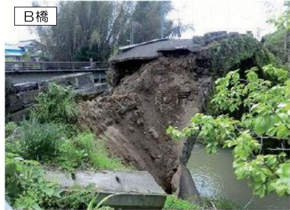
輪石・壁石が崩壊
