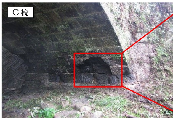
一部の断面が欠損している（輪石下部）
