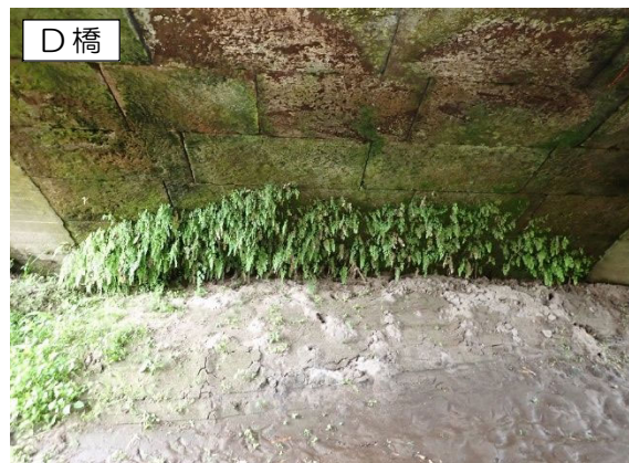
輪石下端部に植生、下面全体に藻類が繁茂
