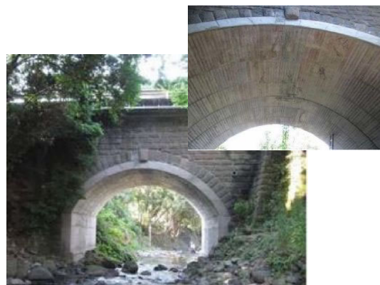
写真-1.4 輪石全体を補強している事例
