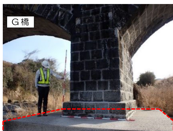
G 橋 対策範囲（コンクリートによる橋台基礎部の補強）
