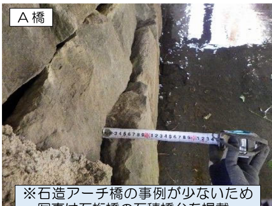
石積橋台に7cm程度のずれ（抜け出し）
