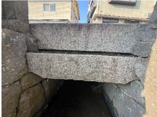
写真-1.5 桁上の床版架設事例
