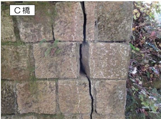
破断が生じている（輪石）
