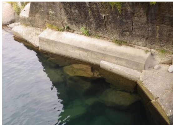
写真-1.3 基礎部分を補強している事例
