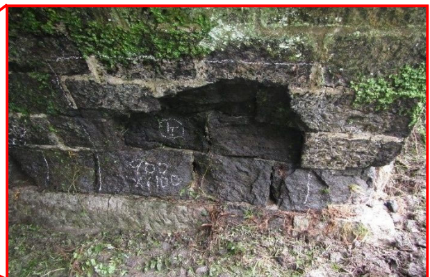
一部の断面が欠損している（輪石下部）
