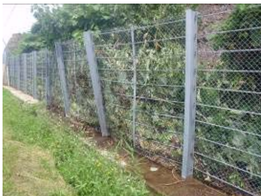
写真 落石防護柵の傾動の例
