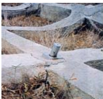
写真 受圧構造物の破損の例
