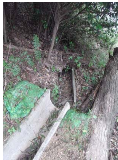
写真 排水溝の破損の例
