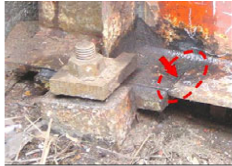
写真3 主桁の亀裂
