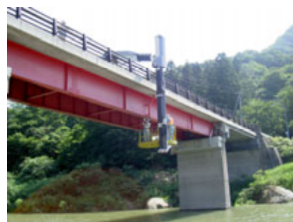
写真1 橋梁点検車による調査状況 (ここまでは、求めている。)
