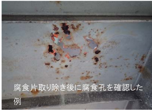
腐食片を取り除いた状態の例（床版）
