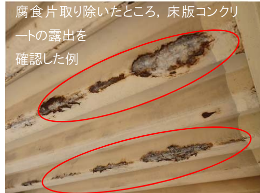
腐食片を取り除いた状態の例（床版）
