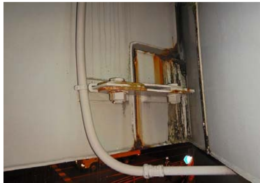
ゲルバー部支承周辺の状態 (主桁・支承部)
