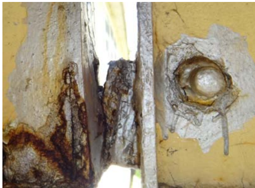
フックの溶接の状態 (接合部)
