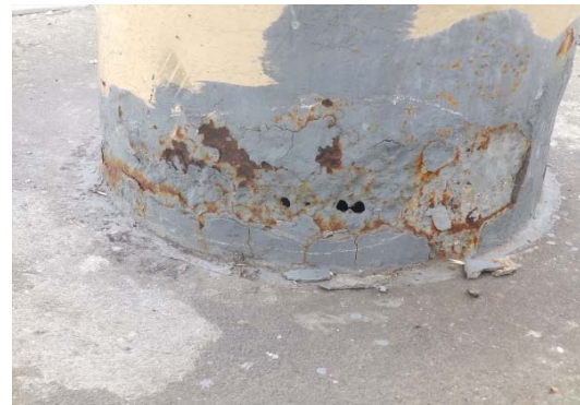
腐食片を取り除いた状態の例（下部）
