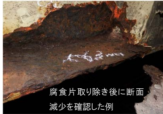
腐食片を取り除いた状態の例（主桁）
