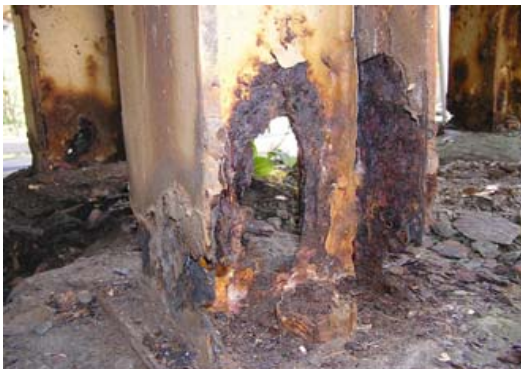
腐食片を取り除いた状態の例（下部）
