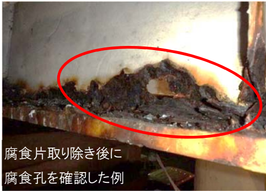
腐食片を取り除いた状態の例（主桁）
