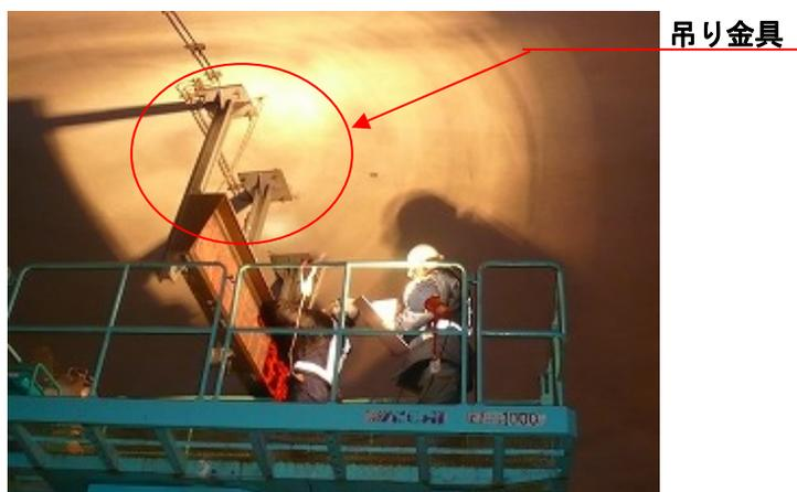
写真-解 6.3 触診作業状況
