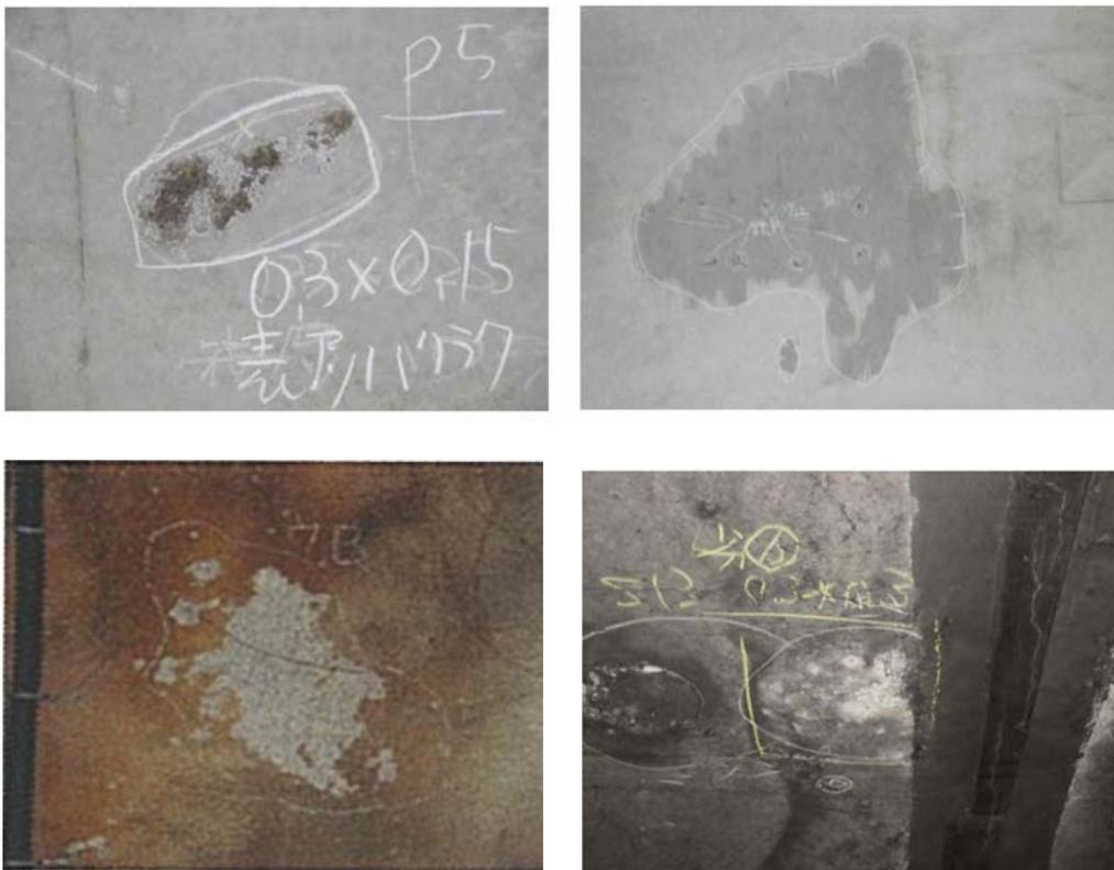
付写真-1.6 覆工コンクリートが変色している例
