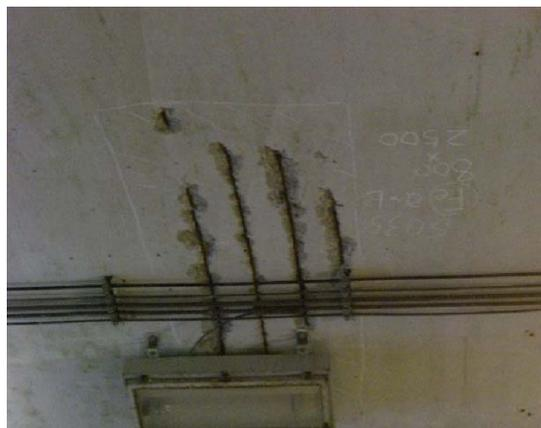
付写真-2.2 鋼材腐食の例
