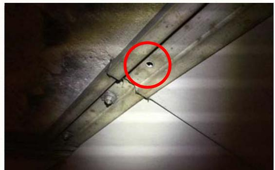
付写真-1.10 導水樋の止め金具が脱落した例
