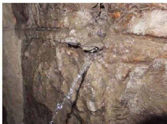
付写真-1.7 漏水（噴出）している例
