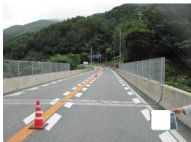
浮き上がりが無いか確認する
