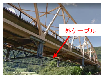
鋼橋の外ケーブル補強の例
