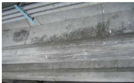
※写真はPC桁下面のひびわれ事例
