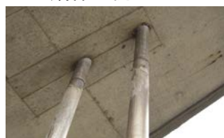
ステンレスの管で保護されている
