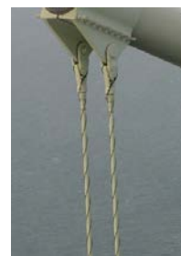
被覆されたハンガーに制震ロープが配置されている例
