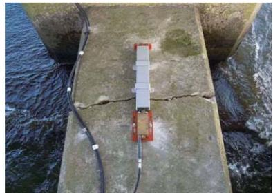
橋脚隅角部の既存ひびわれに対するセンサー(光学伸縮計)設置
