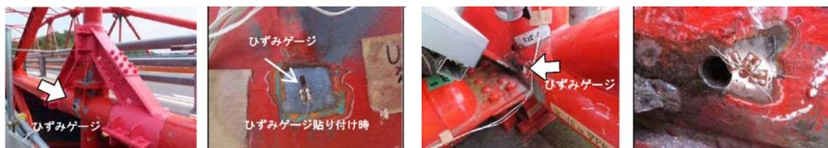
格点補強部のひずみ計測
