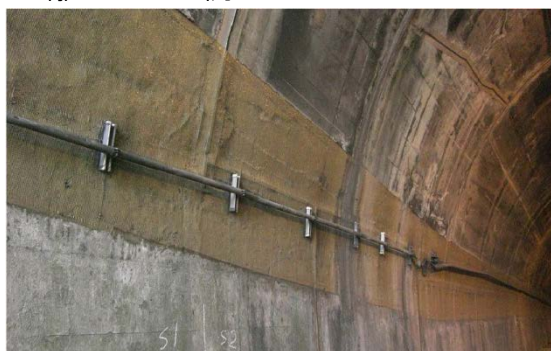
付写真-1.4.7 繊維シートの接着の例
