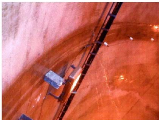
付写真-1.4.3 漏水（噴出）している例
