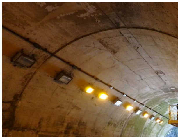
付写真-1.2 覆工の天端付近に発生した縦断方向のひび割れの例
