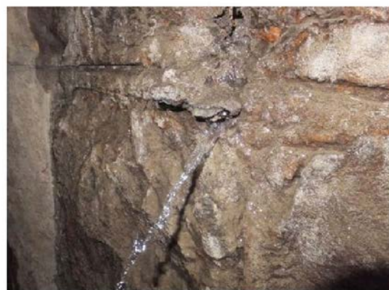
付写真-1.4.3 漏水（噴出）している例
