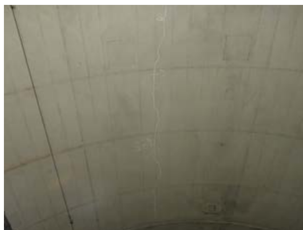
付写真-1.2 覆工の天端付近に発生した縦断方向のひび割れの例
