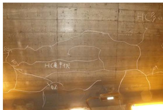
付写真-1.4.1 複数のひび割れで覆工コンクリートがブロック化している例
