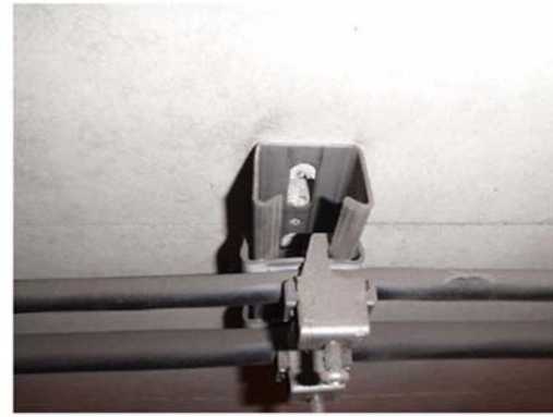
写真-1 固定金具の腐食とアンカーボルトの脱落の例
