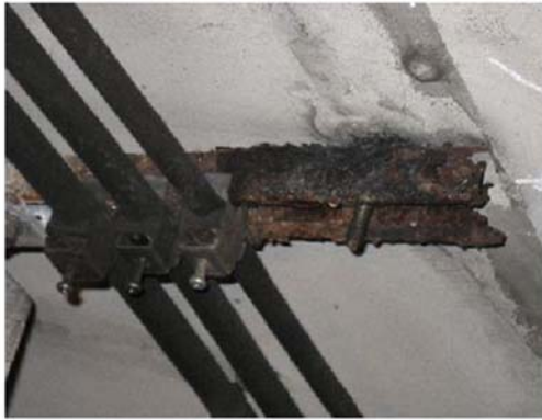
写真-1 固定金具の腐食とアンカーボルトの脱落の例
