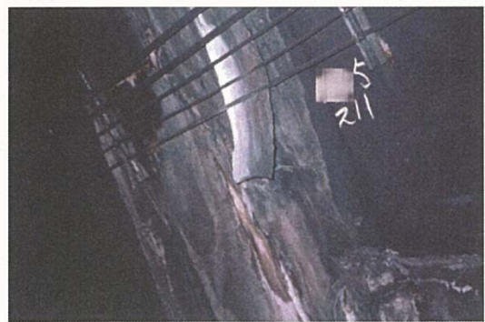
付写真-2.4.5 補修モルタルが劣化してはく離している例
