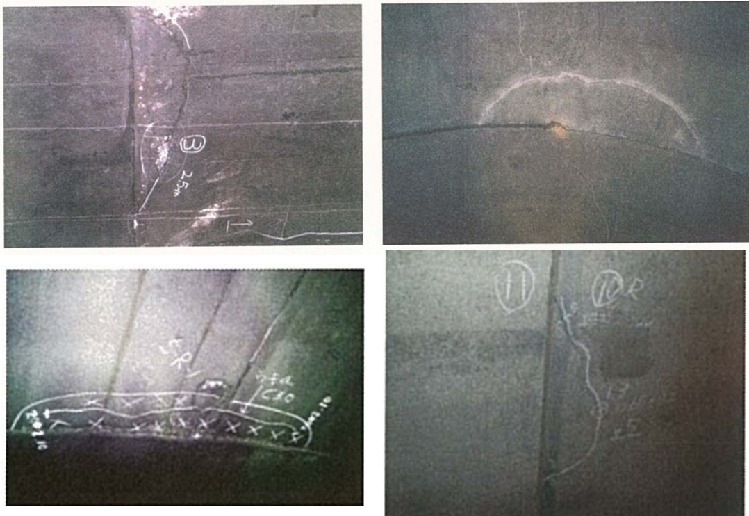
付写真-2.1.1 横断目地の天端付近に発生した半月状のひび割れの例
