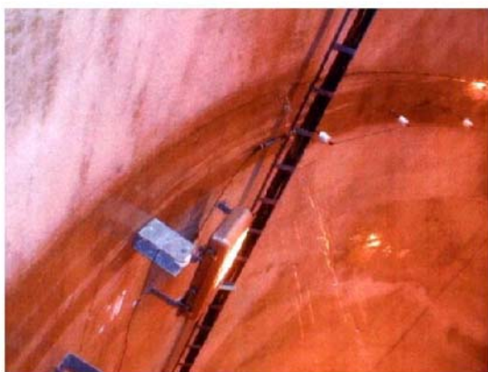
付写真-2.4.3 漏水（噴出）している例
