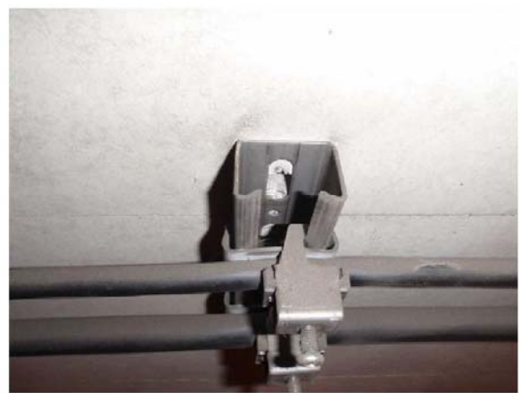
付写真-2.5.1 固定金具の腐食とアンカーボルトの脱落の例
