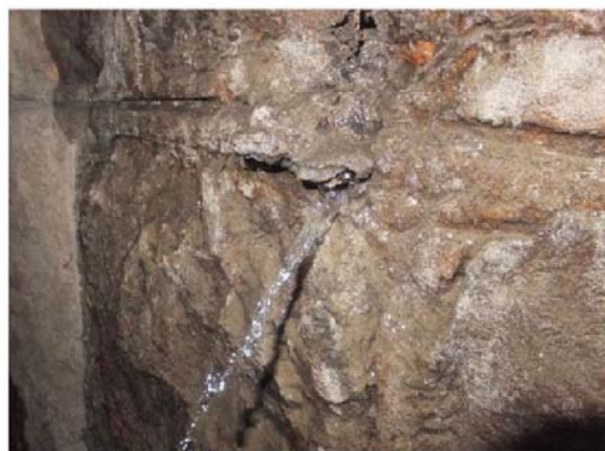
付写真-2.4.3 漏水（噴出）している例
