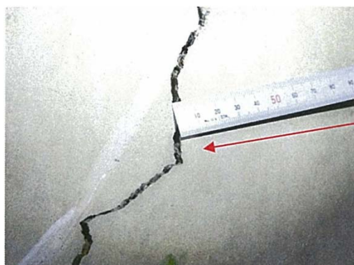
付写真-2.3.1 覆工スパンの中間付近に発生したひび割れの例
