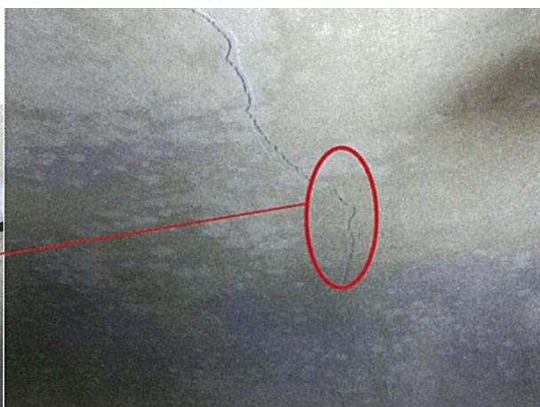
付写真-2.3.1 覆工スパンの中間付近に発生したひび割れの例
