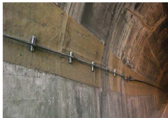
付写真-2.4.6 鋼板接着（左）・繊維シートの接着（右）例
