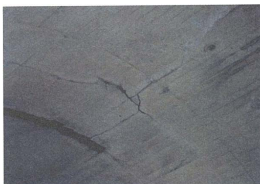
付写真-2.4.1 複数のひび割れで覆工コンクリートがブロック化している例
