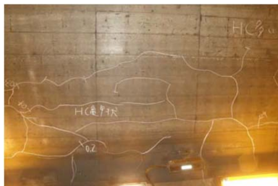
付写真-2.4.1 複数のひび割れで覆工コンクリートがブロック化している例
