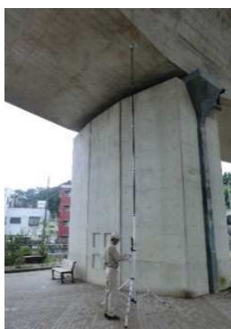
高所型を用いた点検
