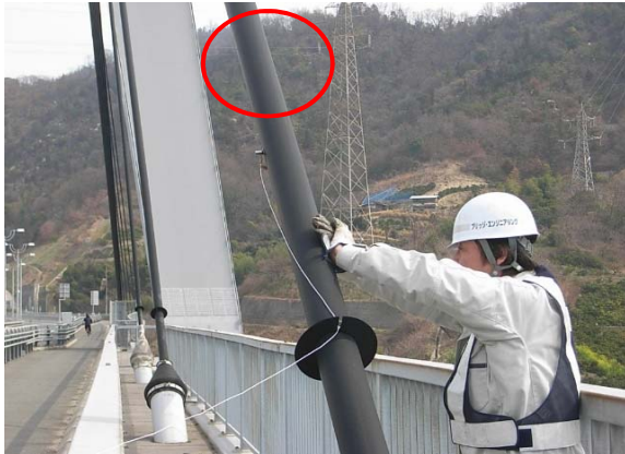
センサー(加速度計)の取り付け
