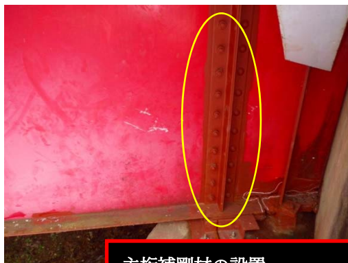
主桁補剛材の設置
