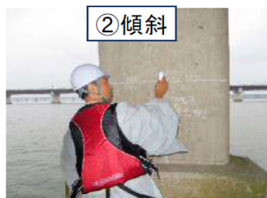
柱の傾斜測定
